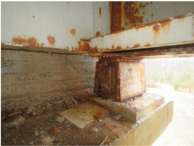
Фильтрация воды по балкам в опорных зонах. Разрушение бетона на глубину более 30 мм, трещины, оголение, коррозия арматуры
