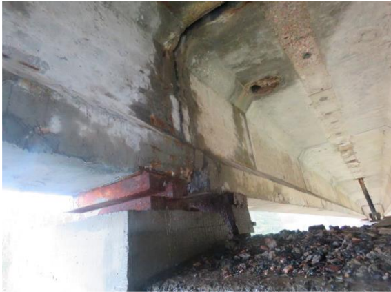
Фильтрация воды по балкам в опорных зонах. Разрушение бетона на глубину более 30 мм, трещины, оголение, коррозия арматуры
